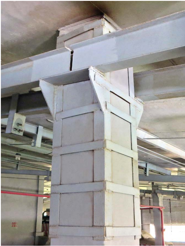
Усиление железобетонной колонны металлической обоймой
