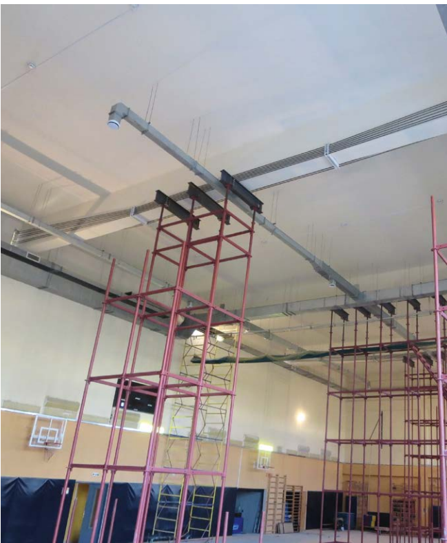
Усиление железобетонного перекрытия преднапряжёнными арматурными канатами
